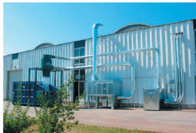
Un impianto completo per imballaggio flessibile che serve sei macchine taglierine.
